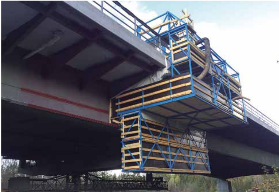
Äußere Arbeitsbühne für den Korrosionsschutz von Stahlbrücken
