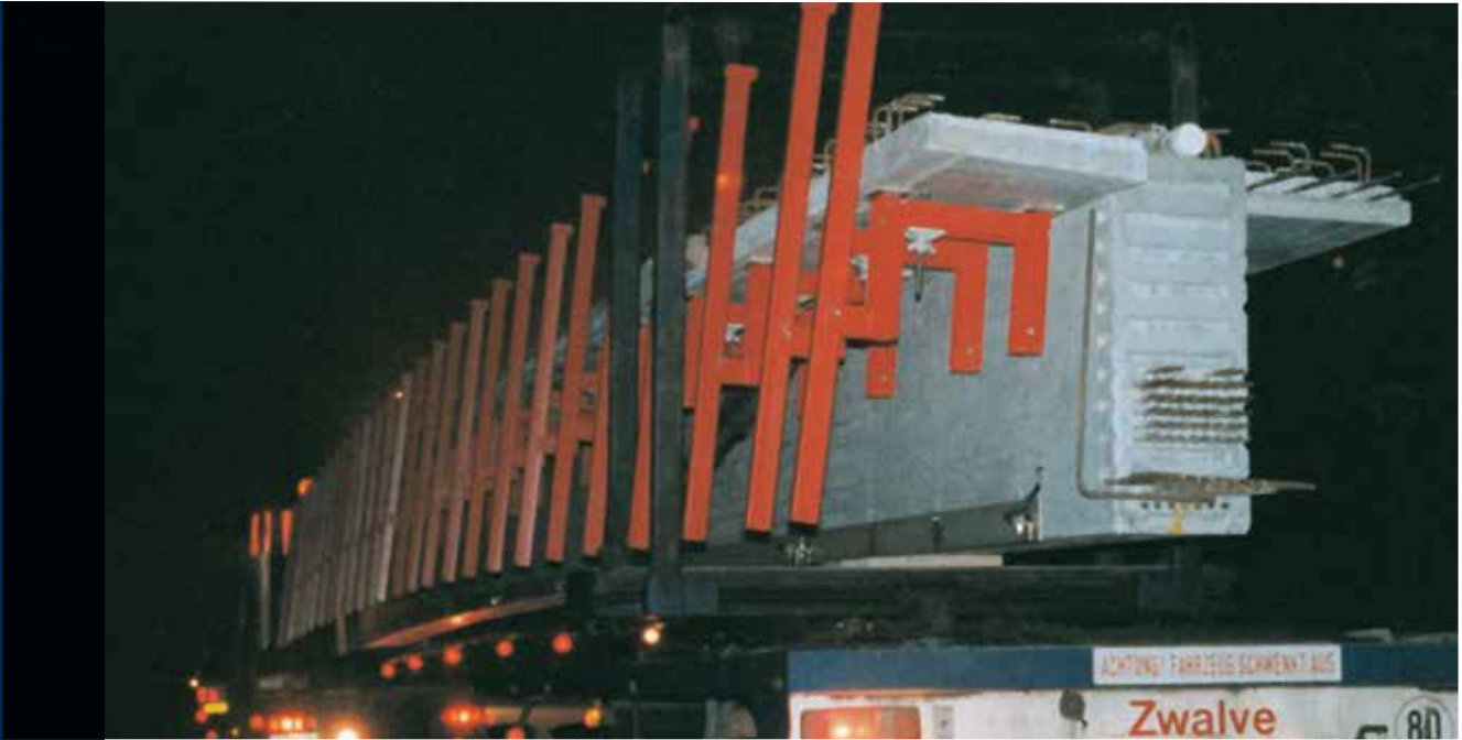
Kappenriegel SF / Transport zur Baustelle
