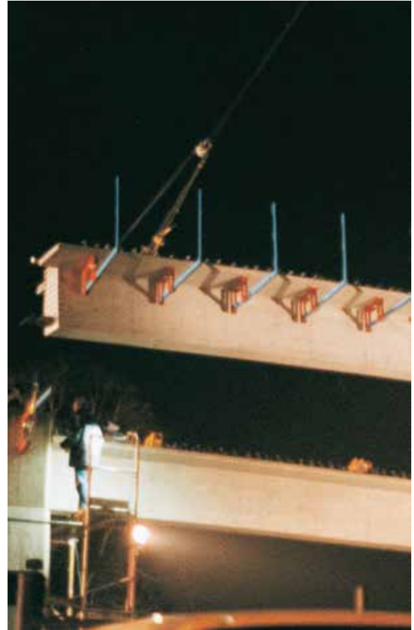
Kappenriegel SF / einfache Montage auf der Baustelle
