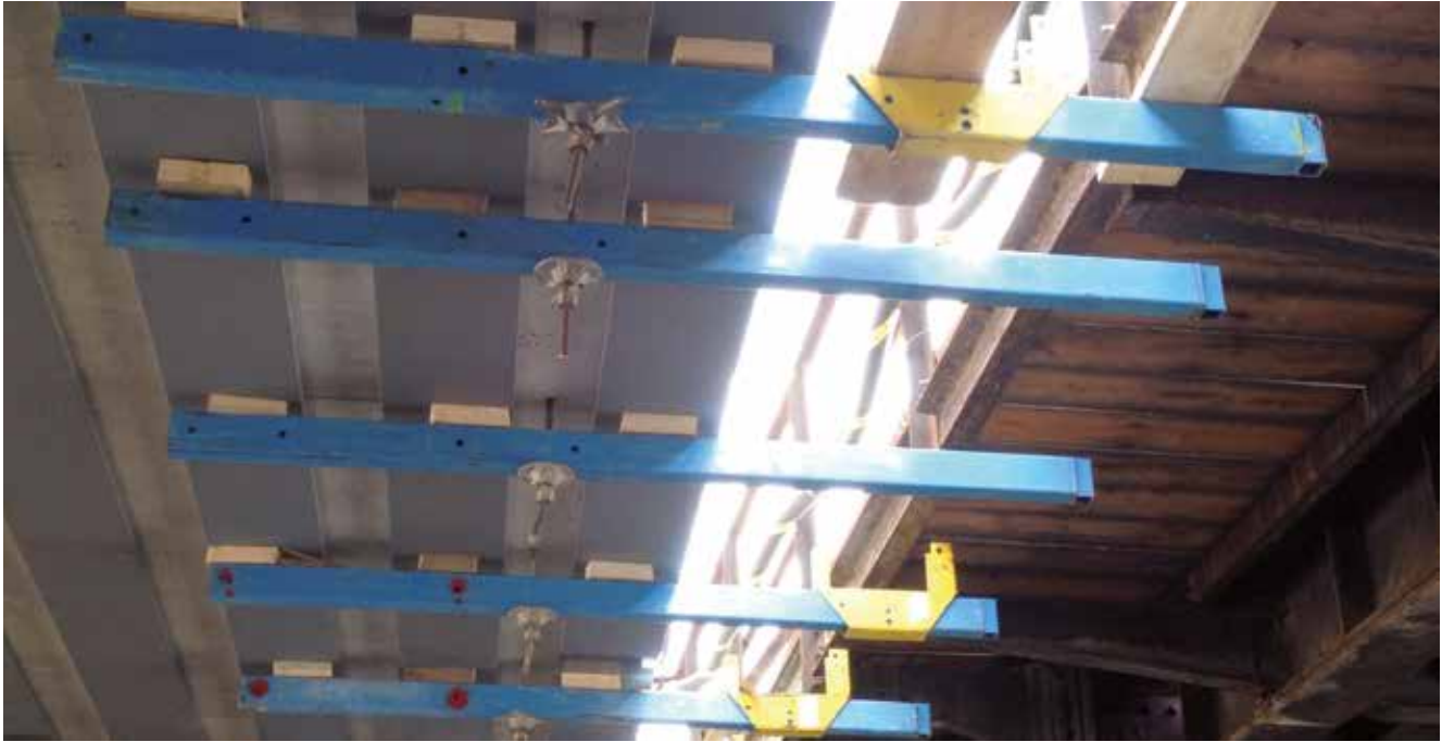
WIB-Überbau-Mittelschalung
